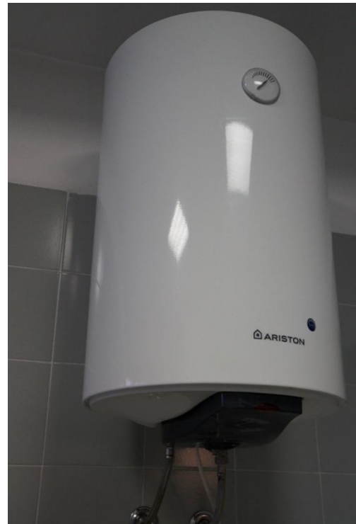
Figura 4.19 - Particolare di un boiler elettrico per la produzione di acqua calda sanitaria
