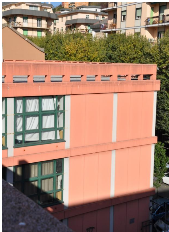
Figura 1.1 - Vista della facciata sud-est
