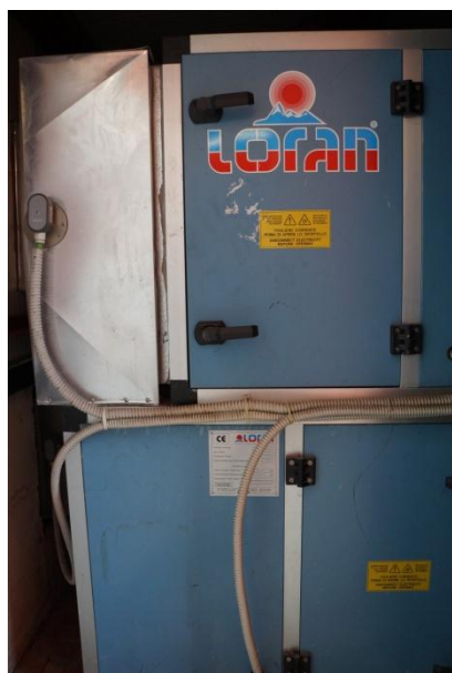
Figura 4.14 - Particolare dell'UTA a servizio della Palestra
