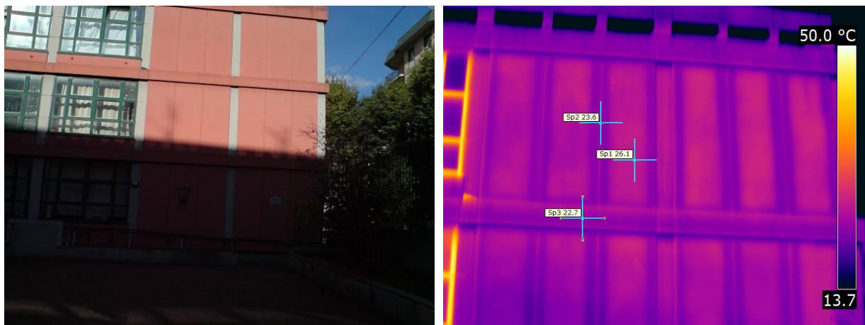
Figura 4.3 – Rilievo termografico della parete orientata a sud est
