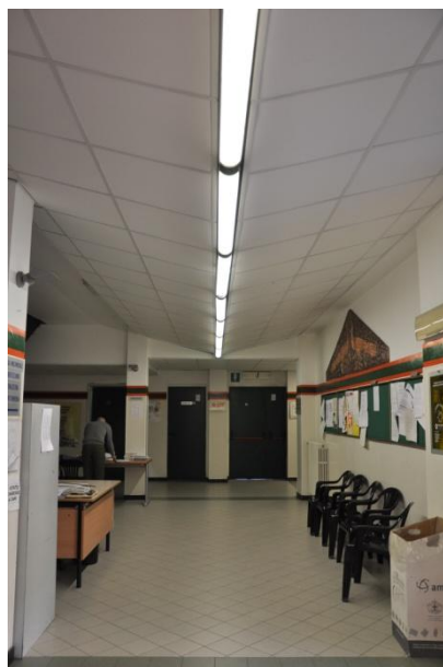
Figura 4.20 - Particolare dei corpi illuminanti ubicati nei corridoi
