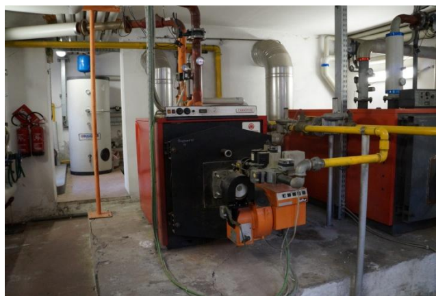
Figura 8.3 – Particolare generatore di calore
