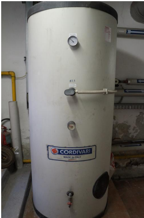
Figura 4.18 - Particolare del sistema di accumulo dell'impianto di produzione ACS combinato
